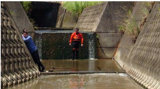
図 1. 堰高 165 cm の垂直堰。写っているのは著者の久米（中央）と渡邊（左）。
