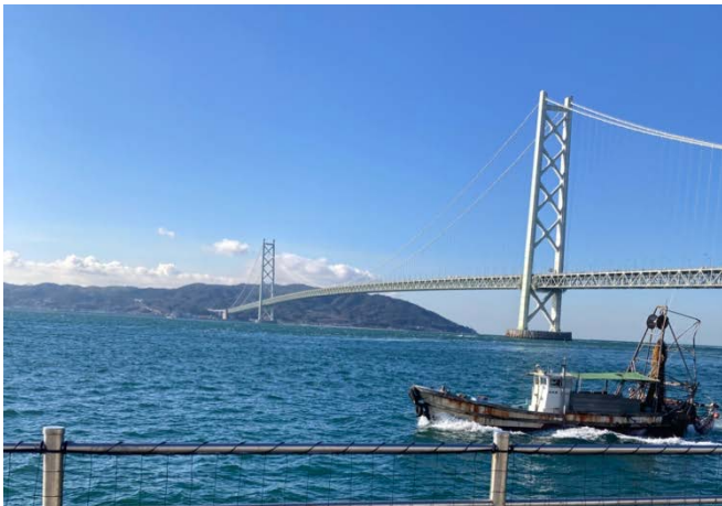
写真1 機器を設置している場所からののオーシャンビュー 明石海峡大橋が見えて気持ちが良いです。
