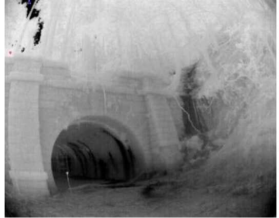
図1. 三重県津市にある廃隧道（サーモカメラにより撮影）。
