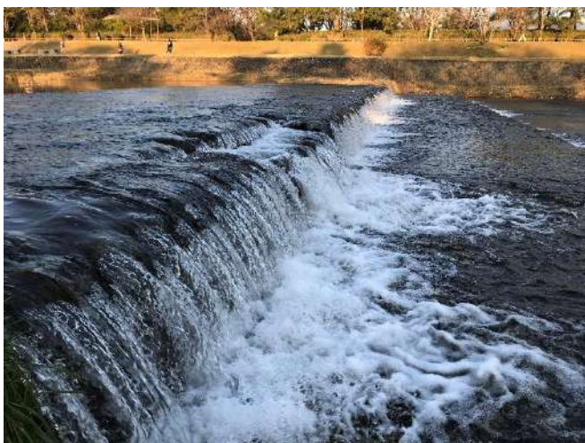
図1. 調査地にある落差工の一つ。追跡個体が遡上した2つは、V字状の破損個所があるものと一部が繁茂した植物で覆われたもので、足掛かりになると考えられた。
